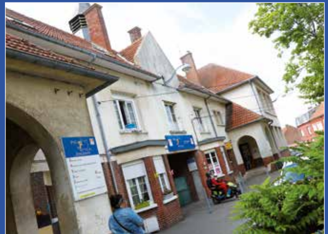
Maison de service et de proximité Jean Jaurès
